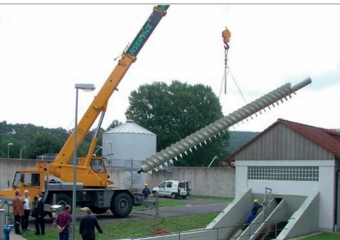
Installation einer aufgearbeiteten Förderschnecke für das Klärwerk Lohr a. Main, Deutschland. Neben der Aufarbeitung der Schneckengeometrie und der Lagerstellen wurde der Ein- und Ausbau durchgeführt.
